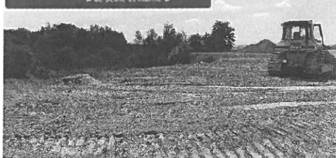
Les travaux de remblaiement devraient durer deux ans
